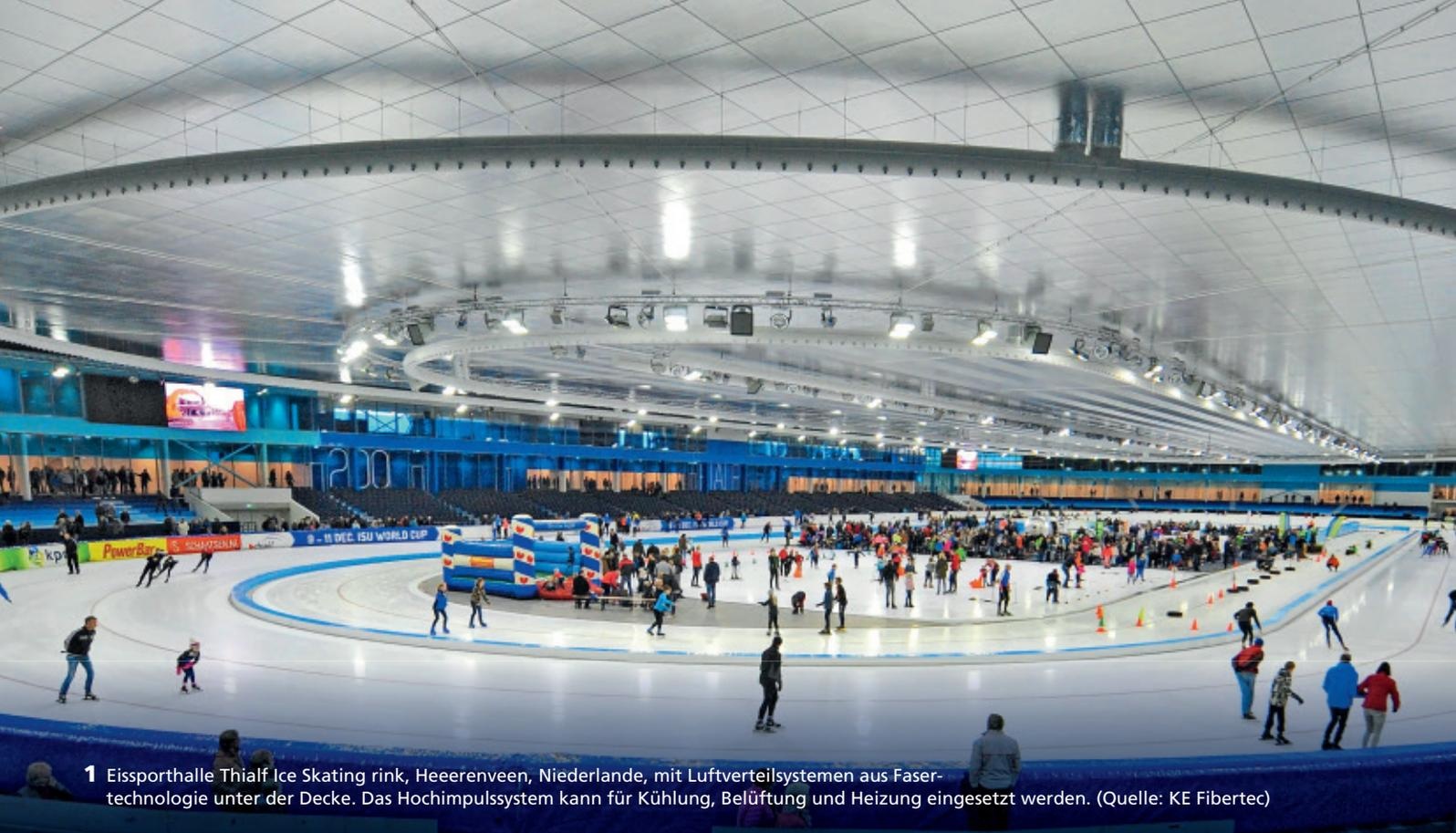
1 Eissporthalle Thialf Ice Skating rink, Heerenveen, Niederlande, mit Luftverteilsystemen aus Fasertechnologie unter der Decke. Das Hochimpulssystem kann für Kühlung, Belüftung und Heizung eingesetzt werden. (Quelle: KE Fibertec)
