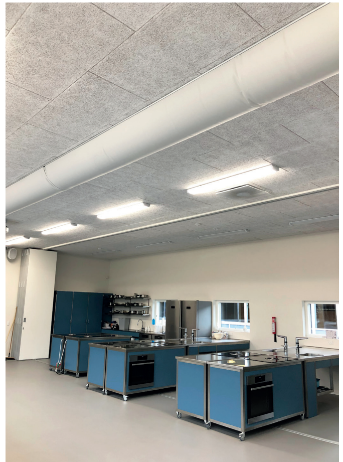
I faglokalet til hjemkundskab er der også monteret tekstilkanaler
