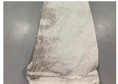
Tekstilkanal monteret i meget fugtigt miljø og efter flere år uden vedligehold.
