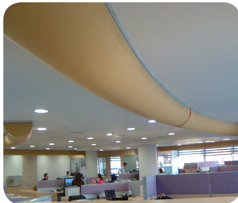
KE-Interior® System mit gebogenen Luftverteilschläuchen und Schienen
