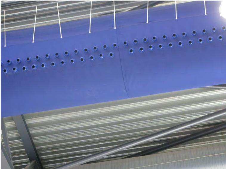
Abwärme wird für die Erwärmung der Hallen zurückgewonnen (> 80%). Die gewonnene Wärme wird durch DireJet-Systeme effizient in den Hallen verteilt, so dass die KE-Systeme sowohl für Prozessluft sowie für die Heizung sehr gut geeignet sind.
