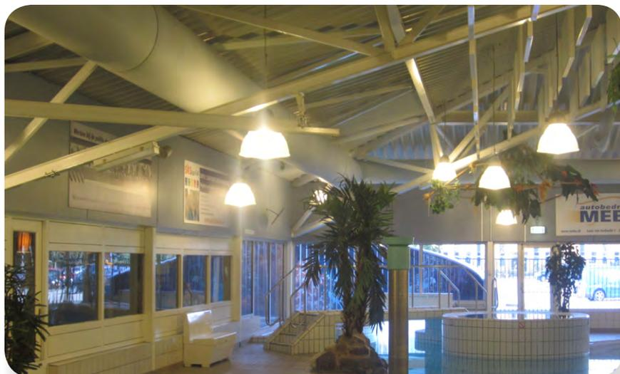
**Innenring** >> Inaktiver Kanal mit ca. 1/3 des gesamten Luftvolumens = 7.500 m³/h
