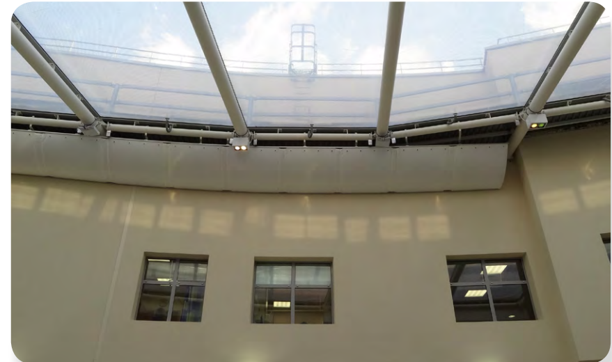
KE DireJet-Textilkanäle mit 24-mm-Düsen
