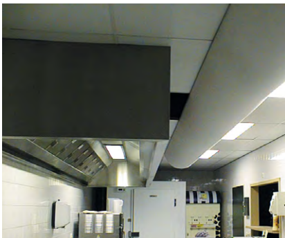
Skibaan, the Netherlands
