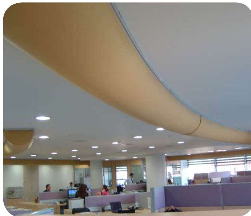
KE-Interiør system med buede tekstilkanaler og skinner
